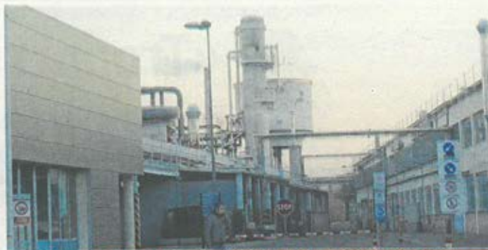
L'ingresso allo stabilimento storico di Abet. In viale dell'Industria
